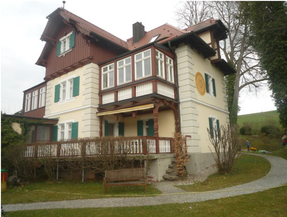
Ansicht Villa von Waldemar Bonsels von Süd-Westen vor Fassadensanierung
