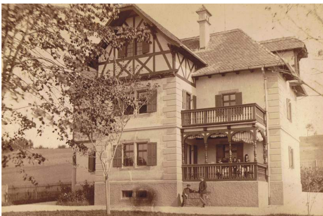
Im Urzustand ist das 2. Obergeschoss noch nicht verschalt.
